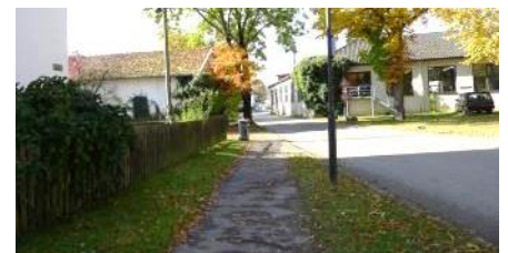
Maroder Gehwegbereich in der Tadinger Straße
