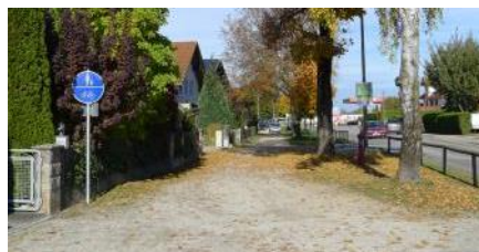
Fuß- und Radweg in Teilabschnitten der St 2331
