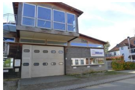
Gewerbehallen in der Ortsmitte an der Tadinger Straße
