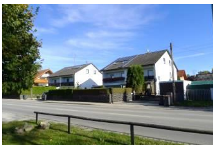
Ortstypische Ein- und Zweifamilienhausbebauung in der Hauptstraße
